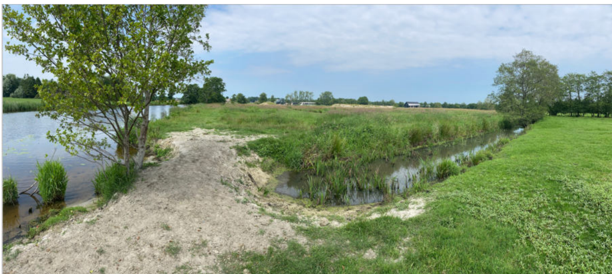
Figuur 18. Dam aan het einde van de afwateringssloot die in 2019 opgehoogd is.
